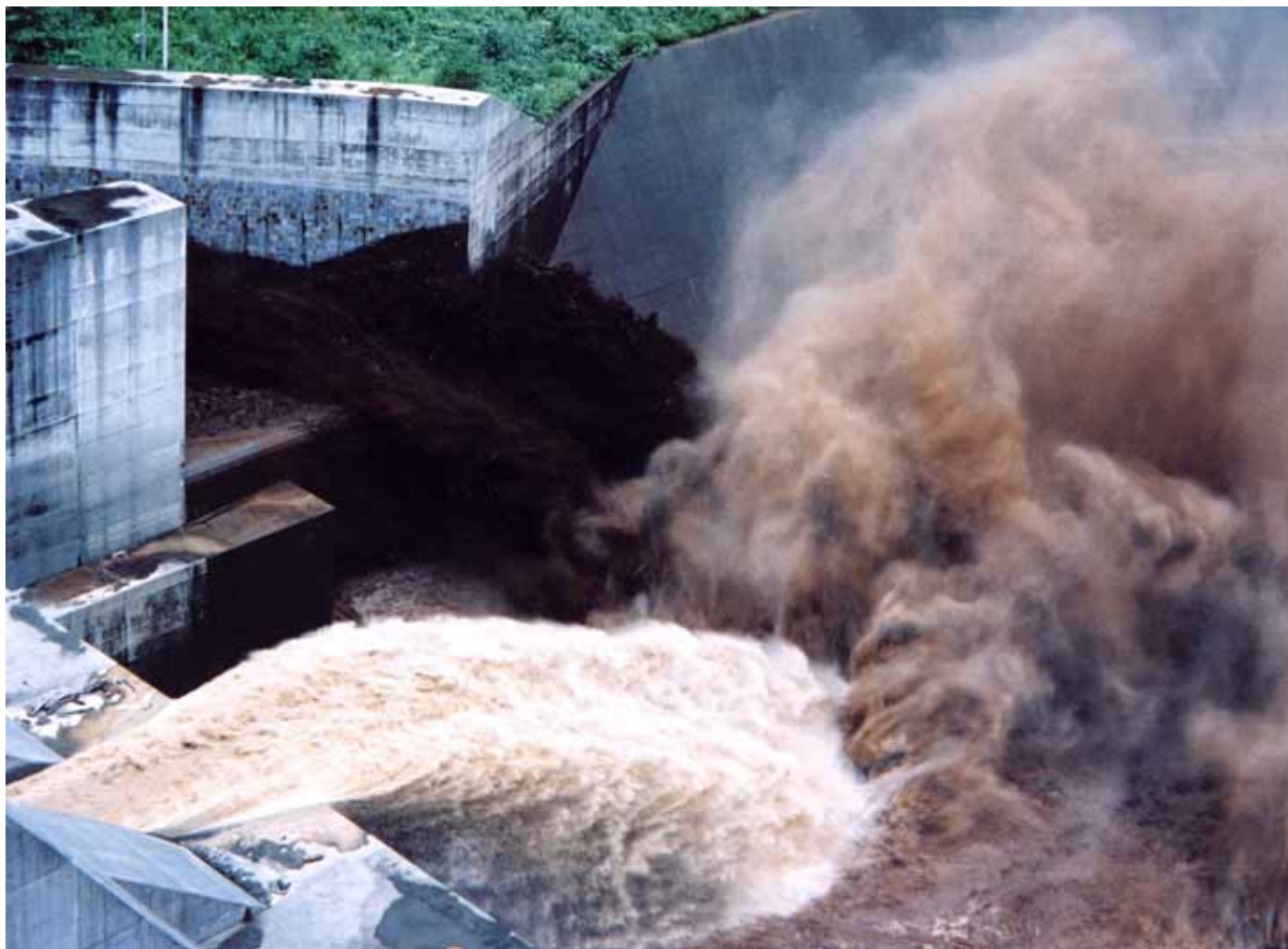
第4図．黒部川流域の宇奈月ダムの洪水ばけゲートと排砂ゲートから流れ出る濁水．2004年7月18日9時半頃撮影．左はしが排砂ゲートであるが、まだ1号しか開いていない．
