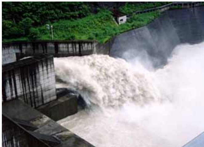
第3図．黒部川流域の宇奈月ダムの排砂ゲートから流れ出る濁水．2004年7月17日15時頃の1回目の自然流下．
